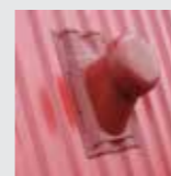
Выход универсальный Металл Профиль Ø110/200 (внутр. Ø/высота) на профнастил С-21.
